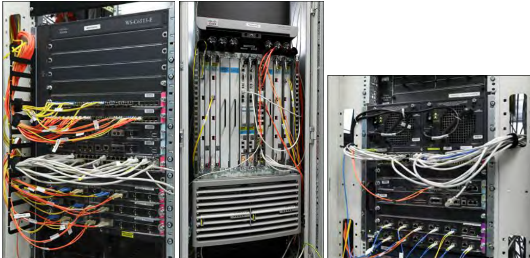
D'esquerra a dreta, el commutador i l'encaminador, ambdós de l'Anella, i per últim, el commutador del CATNIX.
