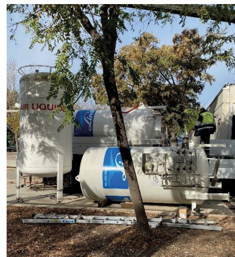
Instal·lació de tancs de gasos de laboratori a la URV.
